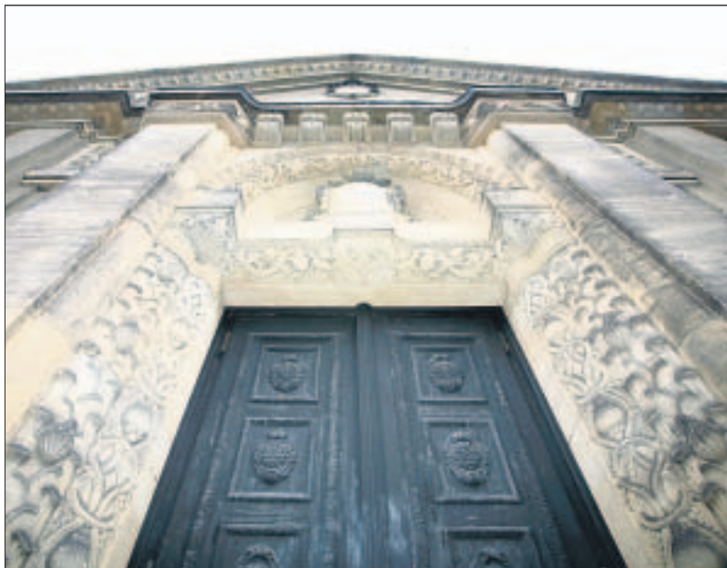
Noch ist er meist verschlossen, der Eingang zur Görlitzer Synagoge. Nach der 289 000 Euro teuren Sanierung soll sie ein Ort der Kultur werden. Foto: Suhrbier
